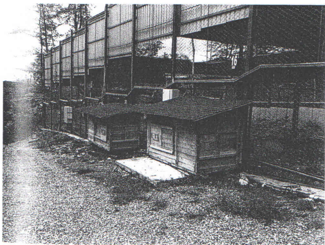
Фото 18. ДЕРЕВЯННАЯ КАМЕРА-ЛОГОВО (ВНЕШНИЙ ВИД).
